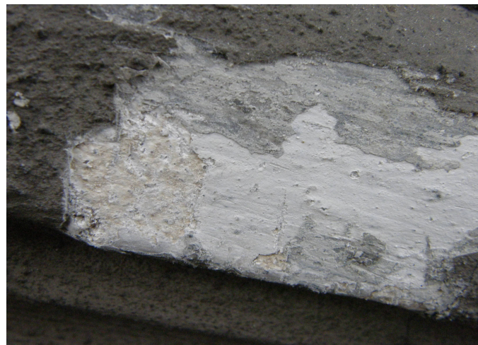
Fot. 3. Jedna z odkrywek wykonanych na elewacji. Pod warstwą obecną widoczna jest warstwa szaro-błękitna, poniżej pobiała i oryginalna warstwa ugrowa.
